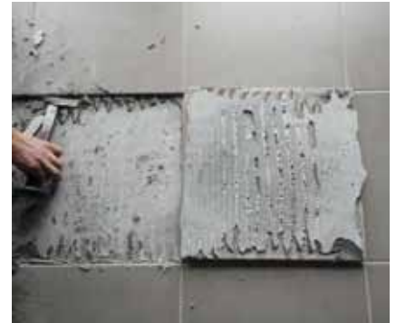
Afb. 2 Ettringietvorming in de mortellijm.
